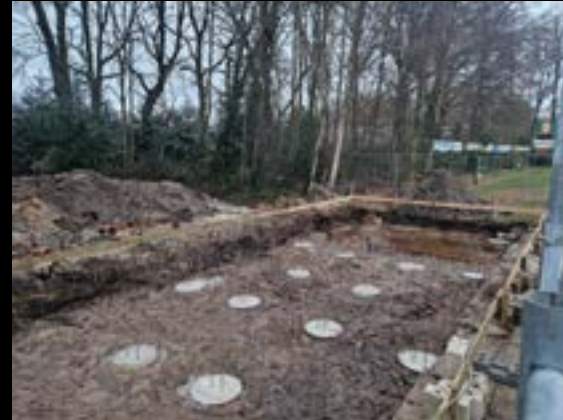
Beton storten: poeren
