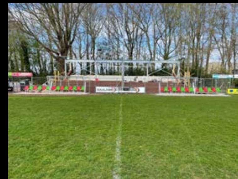
Nieuwe tribune in aanbouw
