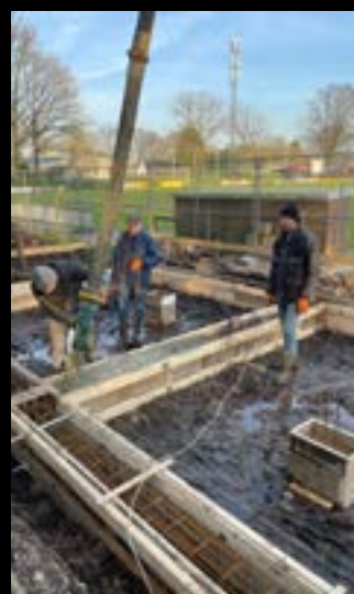
Beton storten: Fundering
