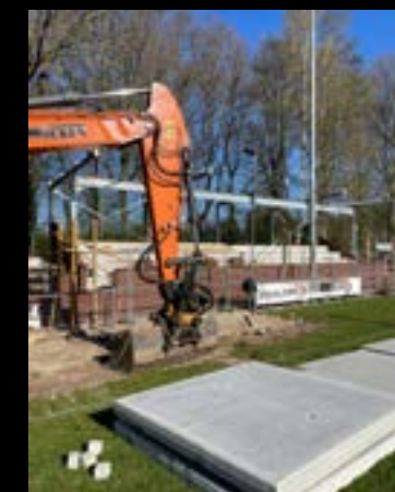
Betonvloer dug outs
