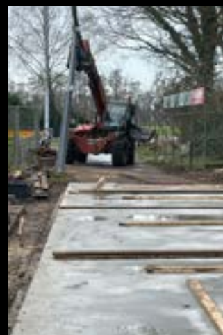
Bouw stalen constructie
